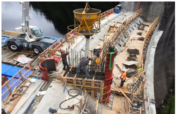
Middle Pier – First Concrete Pour
